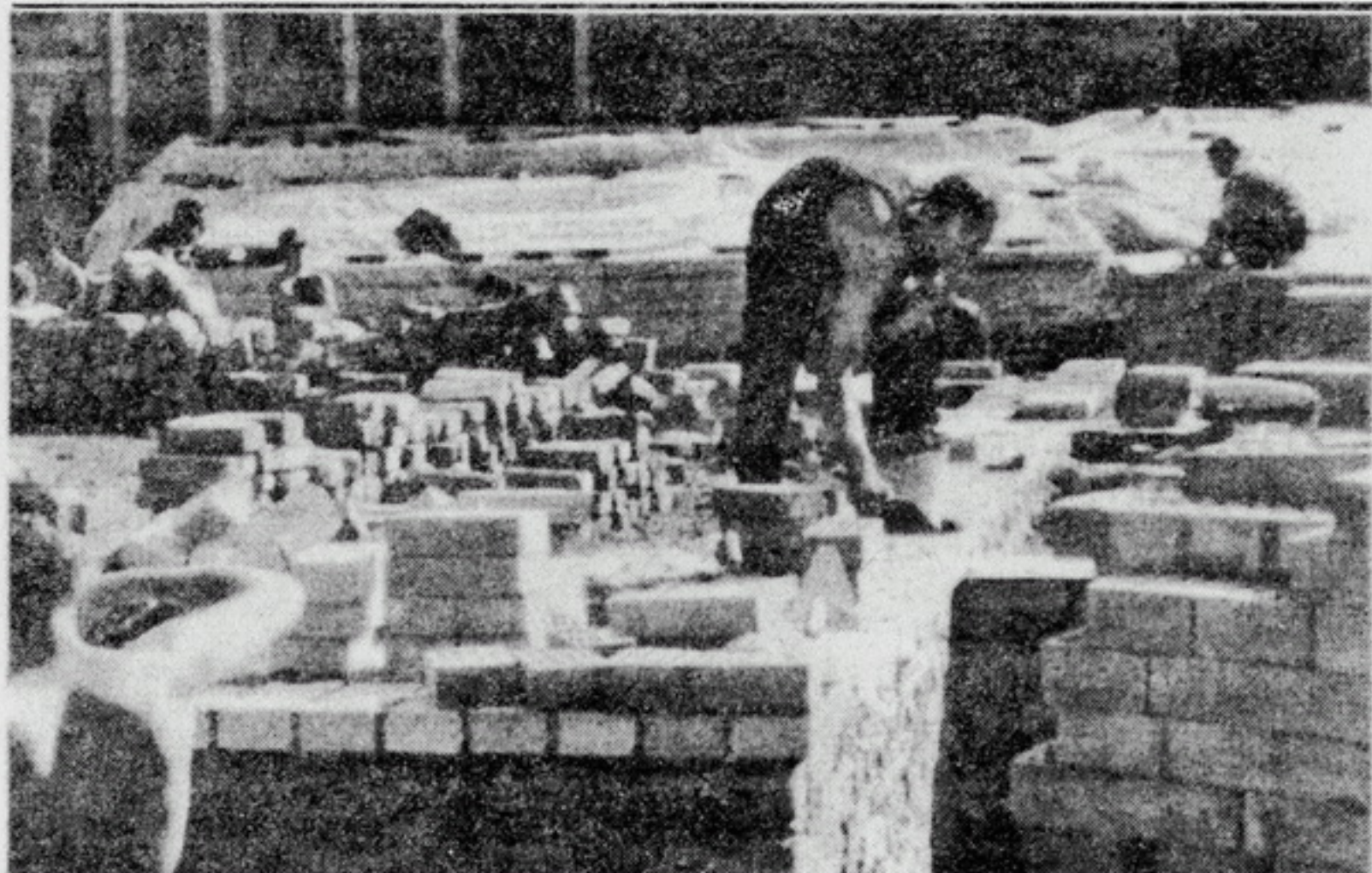
Закладка фундамента будующего храма.
